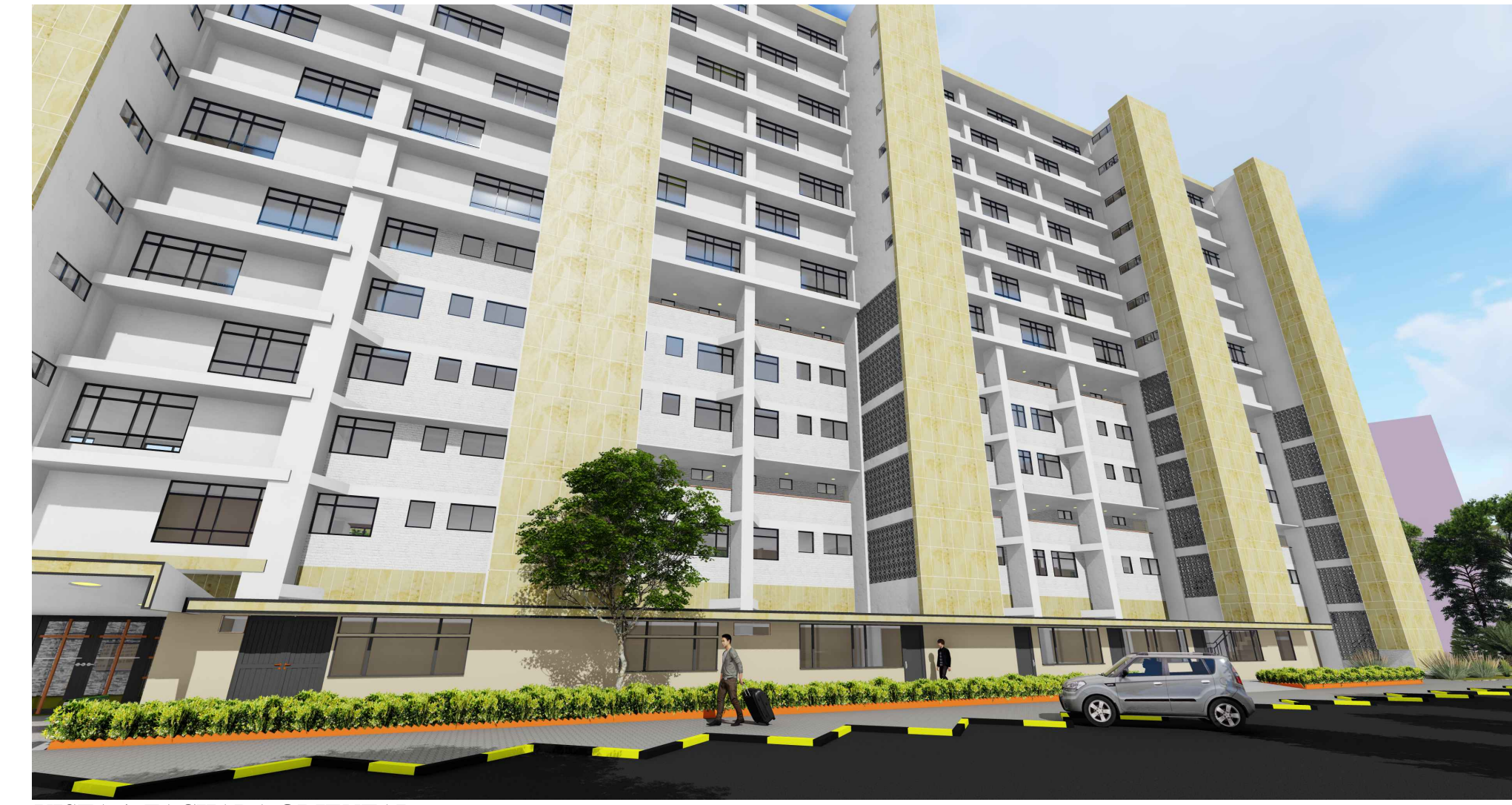
VISTA 1, FACHADA ORIENTAL
