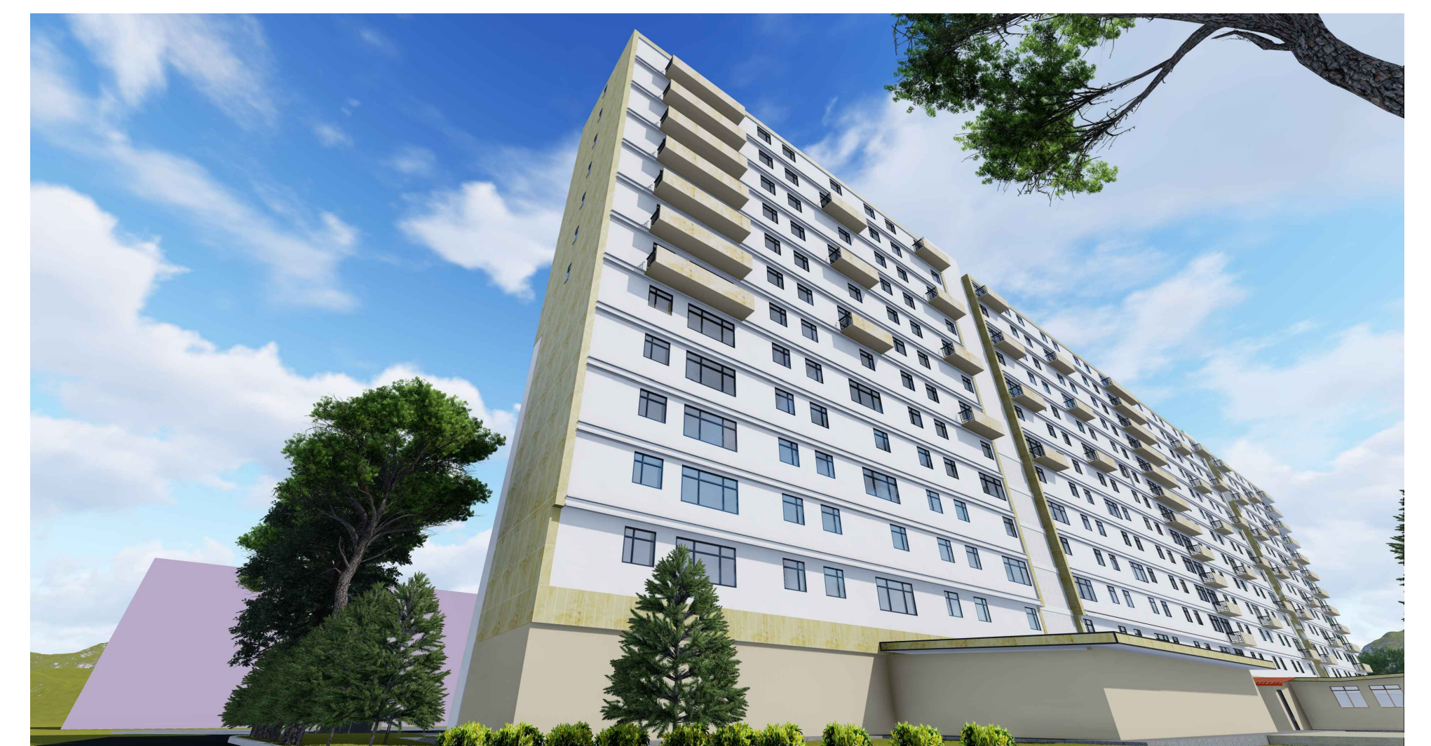
VISTA 4, FACHADA OCCIDENTAL
