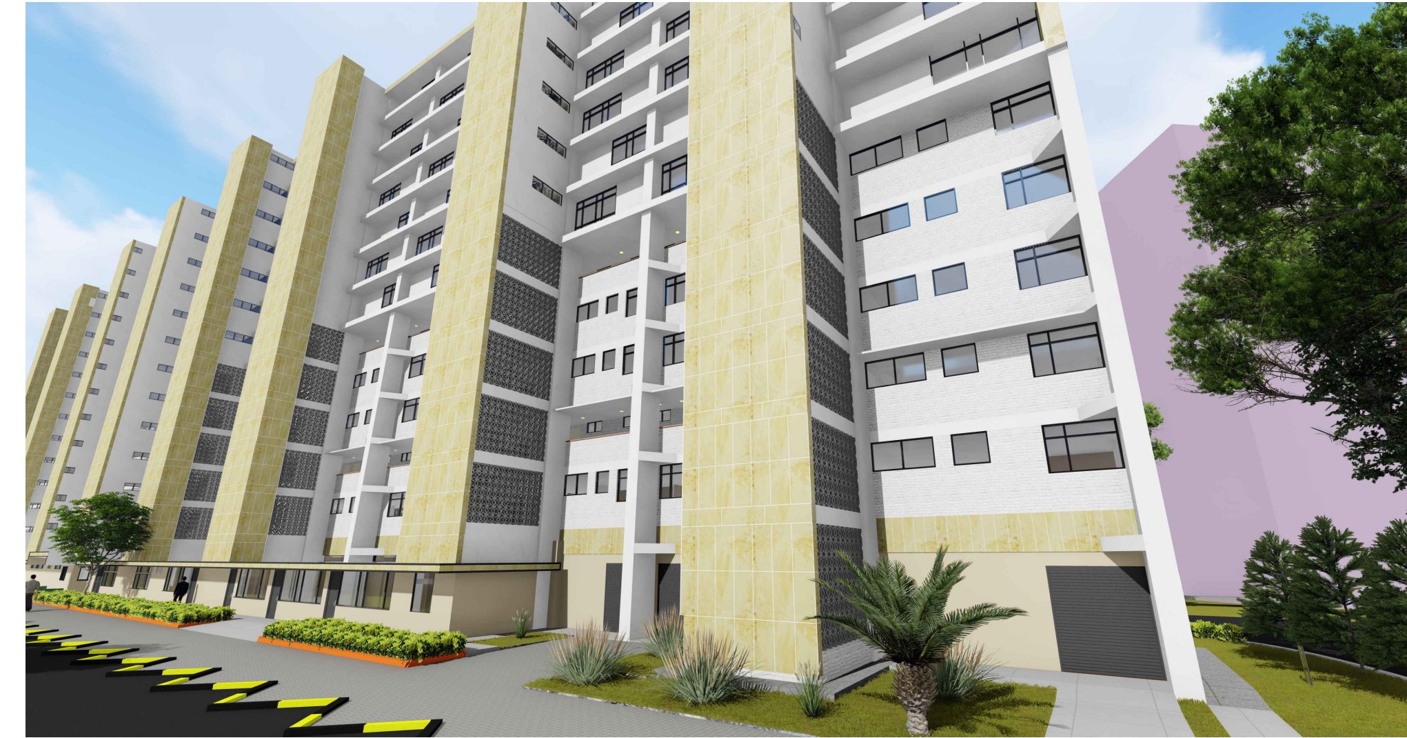
VISTA 2, FACHADA ORIENTAL
