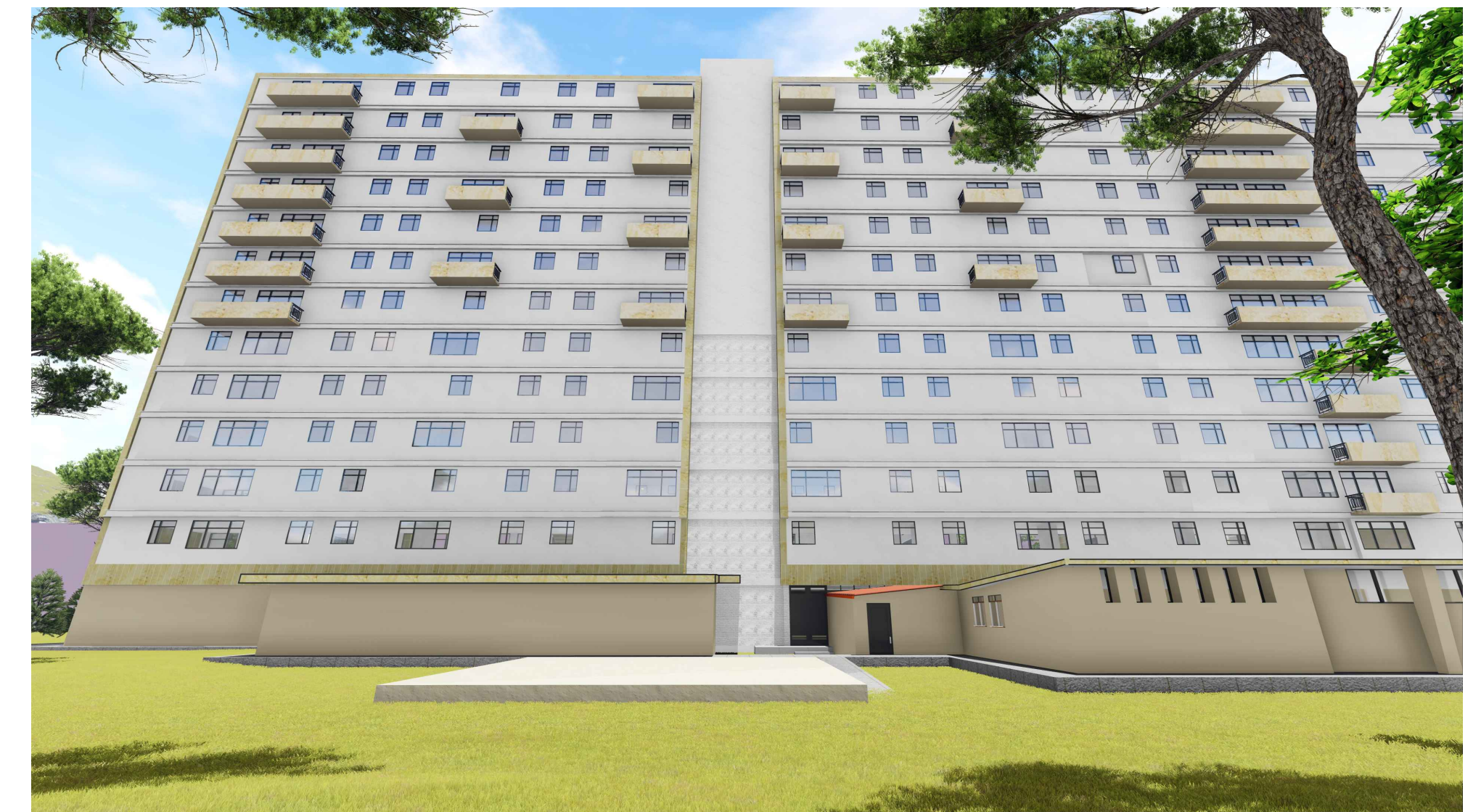
VISTA 3, FACHADA OCCIDENTAL
